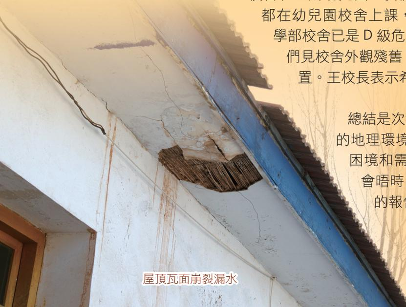
屋頂瓦面崩裂漏水
